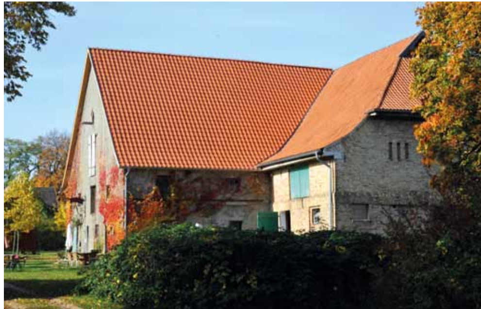
Im Oktober 2012 wurde das Dach des Anbaus unseres Vereinsgebäudes neu gedeckt.
