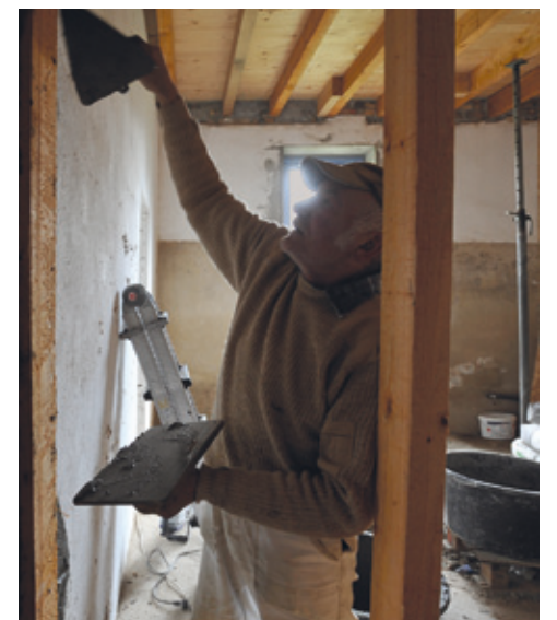
Rudi Schreiber verputzt die Wand.
