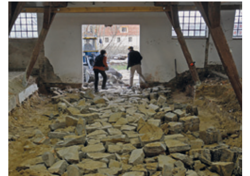
Baustelle der neuen Mosterei
