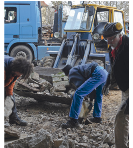
Vor dem Aufbau kommt der Abriss.
